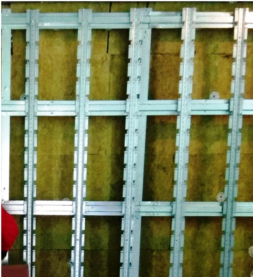
Рисунок 1.3 – Вертикальні профілі – стійка С-1
