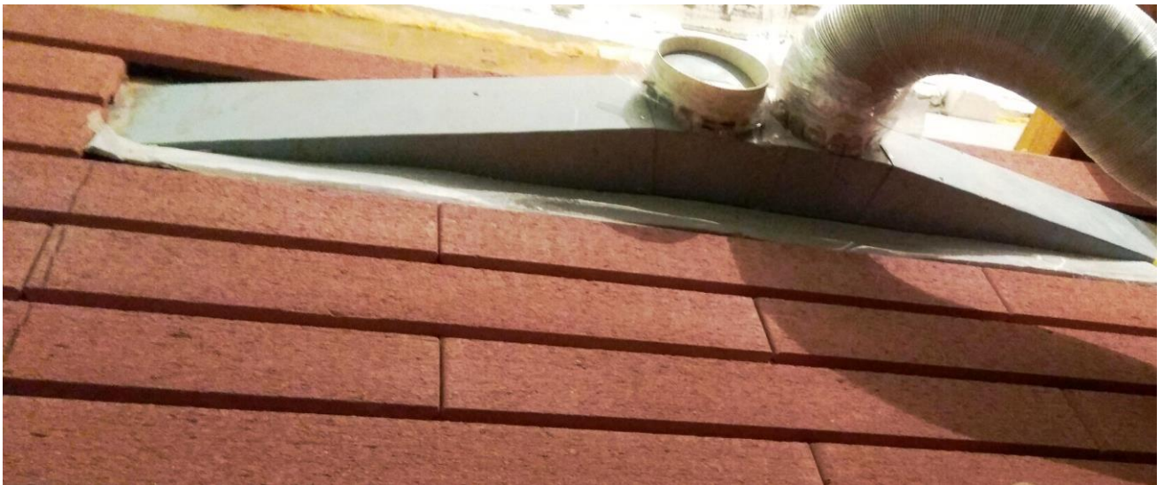
Рисунок 1.11 – Пристрій для створення потоків повітря в прошарку системи утеплення підвищеної швидкості
