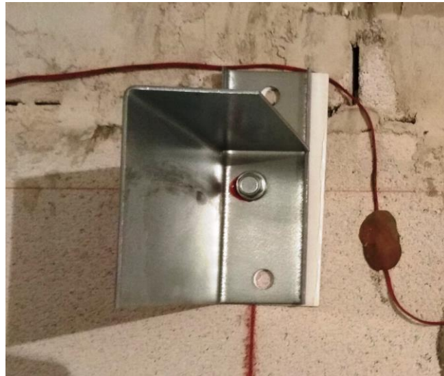
Рисунок 1.4 – Кронштейн – К-1 з термопрокладкою, для кріплення горизонтальних профілів
