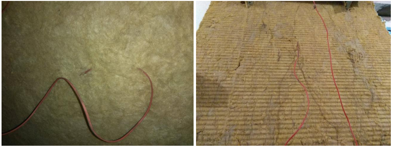
Рисунок 1.10 – Встановлення термодатчиків на поверхнях утеплювача з мінеральної вати
