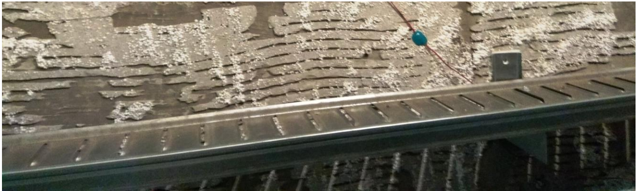
Рисунок 1.2 – Горизонтальний профіль з перфорацією – ригель Р-1
