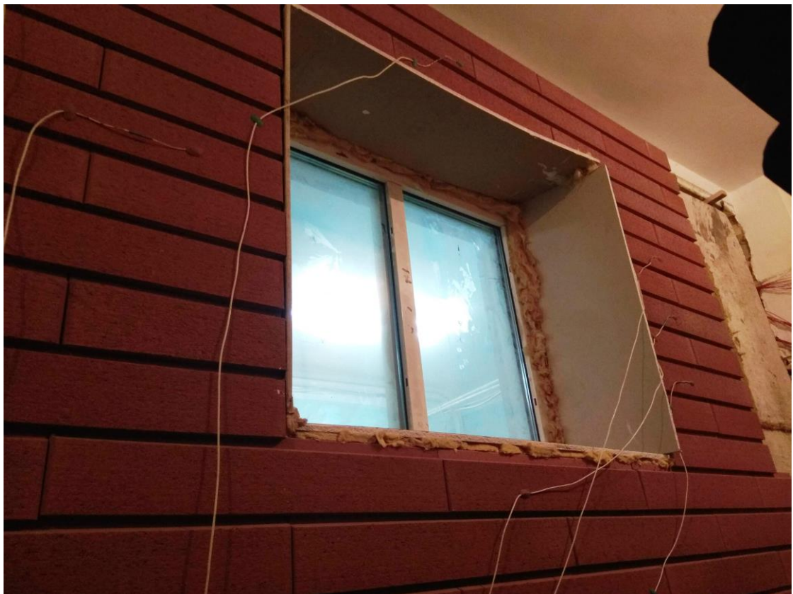
Рисунок 1.6 – Загальний вид дослідної конструкції, на основі кладки з газобетонних блоків, під час випробувань з внутрішньої та зовнішньої сторін
