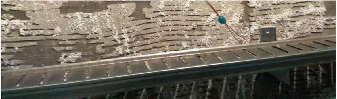
Рисунок 2 – Горизонтальний профіль з перфорацією – ригель Р-1
