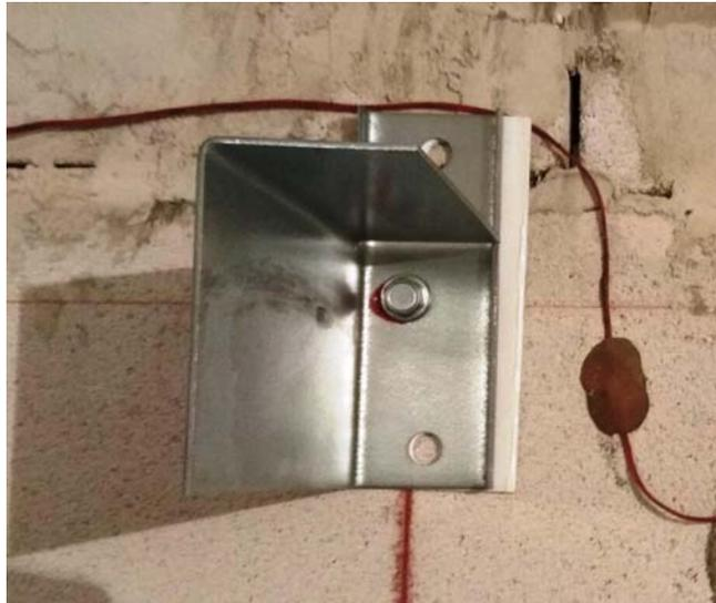
**Рисунок 4** – Кронштейн – К-1 з термопрокладкою, для кріплення горизонтальних профілів
